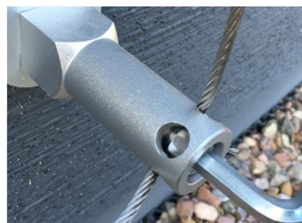
Umlaufendes Seil mit der Hand straff ziehen. Die vier Eckpunkte mit einem Innen-Sechskant Schlüssel 8 mm leicht anziehen.
