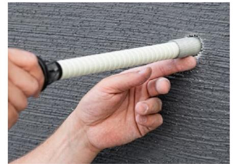
Fassadenanker mit Siebhülse einpassen.
