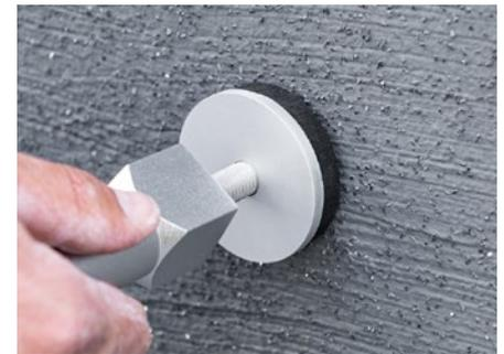
Ranksockel mit Dichtelement aufschrauben, rechts drehend.
