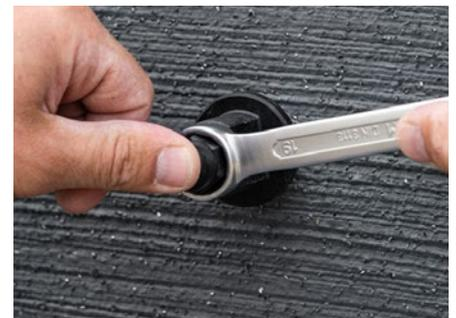
Fassadenanker mittels Montagewerkzeug eindrehen.
