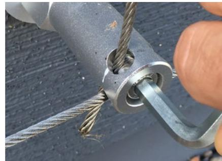
Seilenden mit der Hand straff ziehen Die Enden mit einem Innen-Sechskant 8 mm anziehen.
