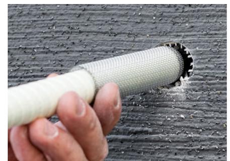
Fassadenanker rechtsdrehend einsetzen.
