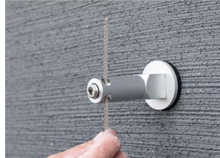
Vertikale Rankseile am oberen Ranksockel durch führen und befestigen Seil nach unten hängen lassen.
